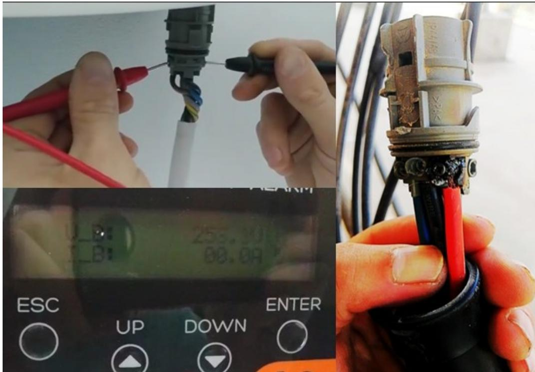
6. Compruebe todas las conexiones de los cables en el lado de CA. Especialmente en los conectores de CA.
